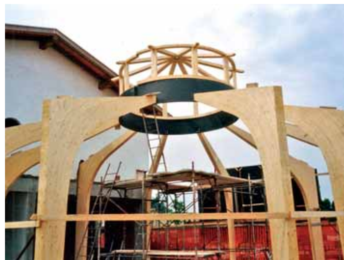
Lavori per la costruzione del nuovo Centro Giovanile tra il 1997 e il 2002: in alto, la zona tendone, sopra la chiesetta, in basso il piano interrato, l'impianto sportivo
