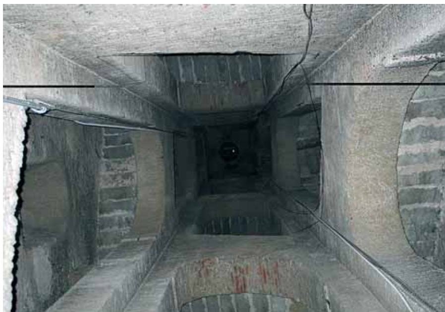
La Torre Civica di Chiari vista dall'interno
