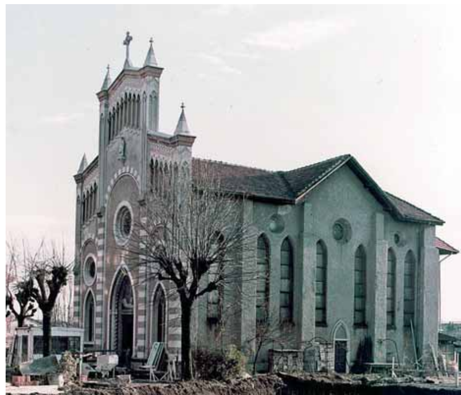
In alto, esterno della Casa di riposo; qui sopra, la chiesa in fase di restauro (fotografie d'epoca conservate nell'archivio dell'Opera Pia Bettolini)
