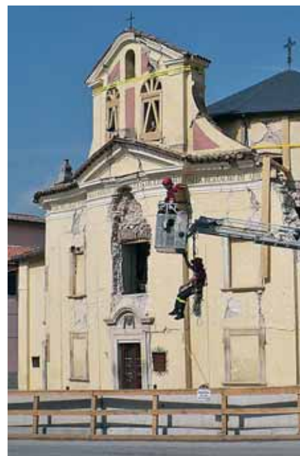
Operai al lavoro presso il duomo dell'Aquila
