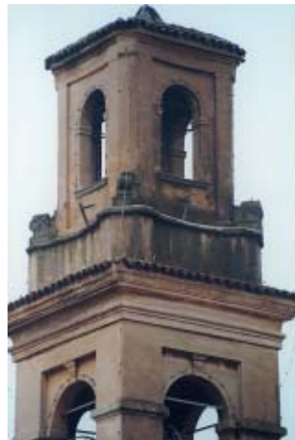
Campanile della Chiesa di San Bernardino, dove verrà installata l'automazione delle campane
