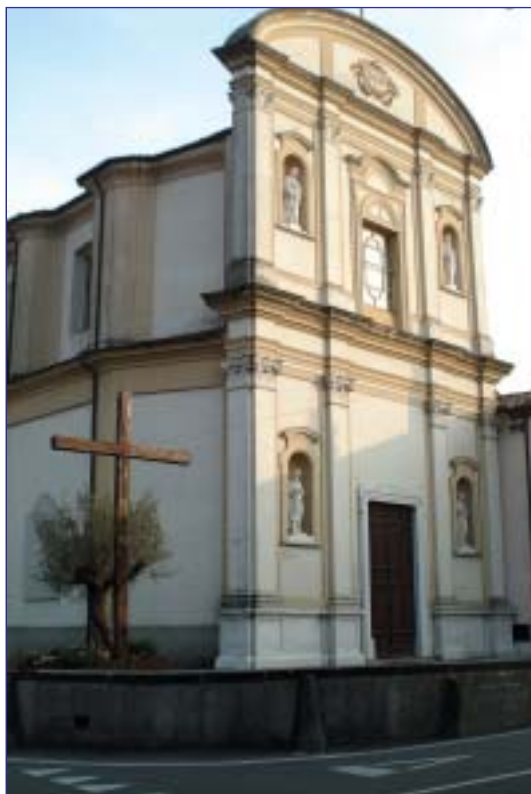
Facciata della Chiesa parrocchiale di Trezano
