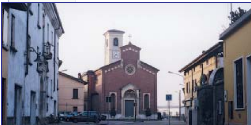
Facciata della Chiesa parrocchiale di Comezzano
