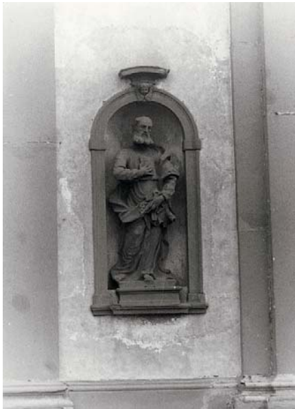
1981: "È decollata l'opera di ristrutturazione della Chiesa del Cimitero" (particolare)
