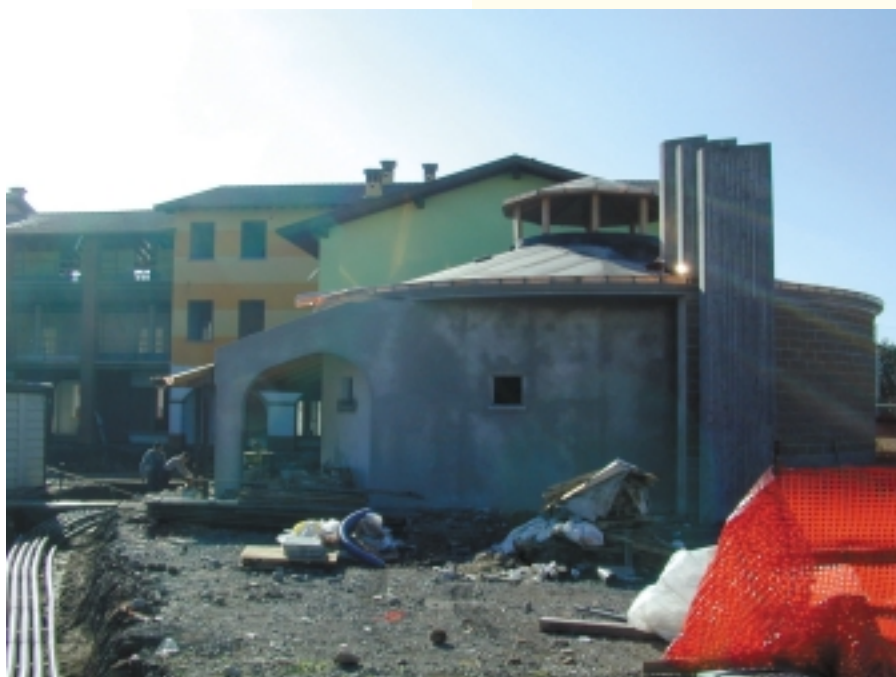
In primo piano, in costruzione, la Chiesa del nuovo Oratorio.
