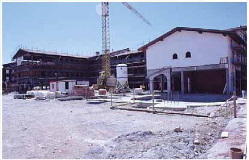
Il Centro Giovanile 2000 in costruzione. Ora i lavori sono ulteriormente avanzati.
