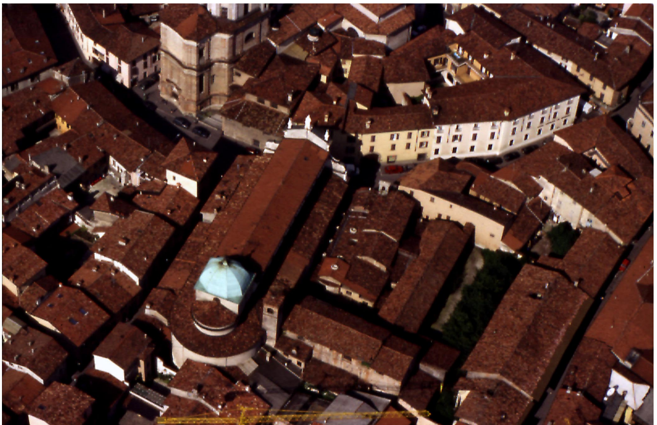
Veduta aerea del complesso di Santa Maria e del Conventino
