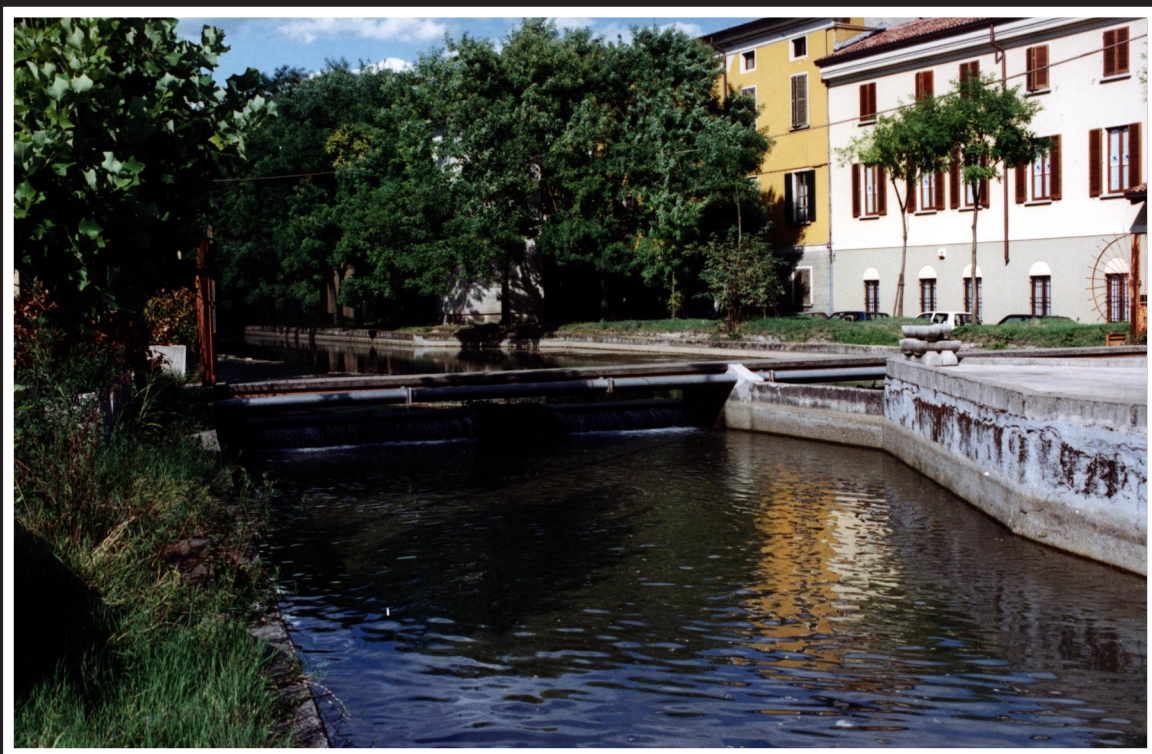
Le acque della Castrina in prossimità dell'attuale Palazzo del Comune
