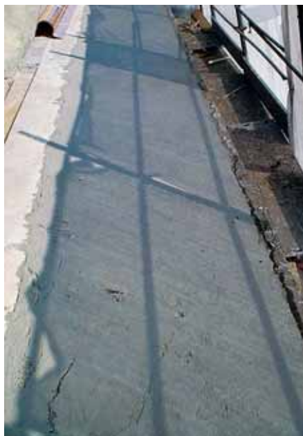
Fasi della costruzione del cornicione e cordolo del tetto della sacrestia del Duomo
