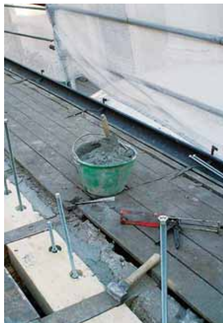
Fasi della costruzione del cornicione e cordolo del tetto della sacrestia del Duomo
