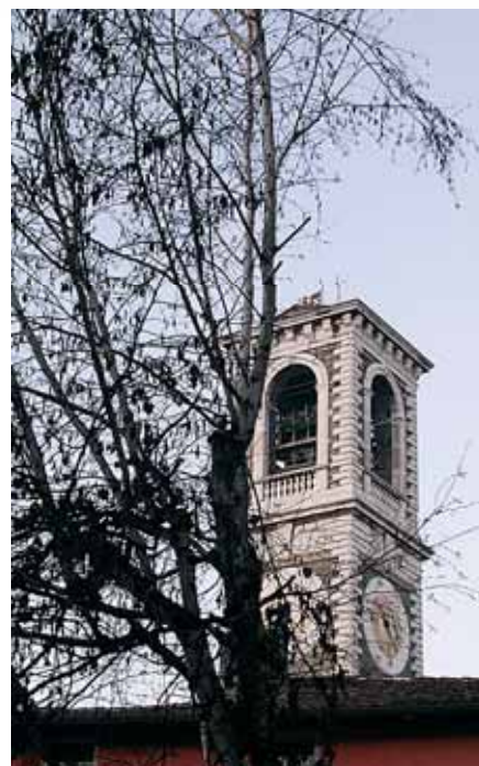
La nostra torre nelle attuali condizioni
